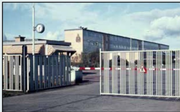
De Tankwerkplaats van de TD, kolonel H.L. van Royenweg 3 in Leusden. Hier in beeld de hoofdpoot met het wachtgebouw, daarachter het kantoorgebouw.
